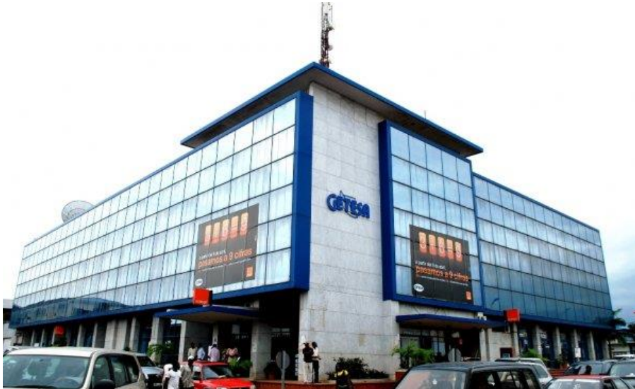
Figura 25: central de telecomunicación de la compañía GETESA
