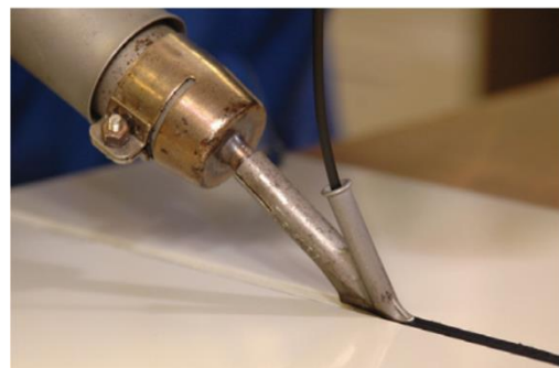
Figura 12. Soldadura mediante aire caliente Fuente: TWI Ltd.
