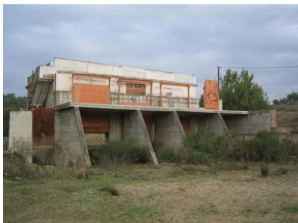
Fig. 78. Central Puente del Obispo.
