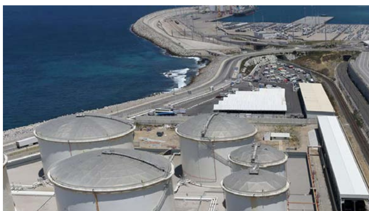
Imagen 4: Terminal de los hidrocarburos
