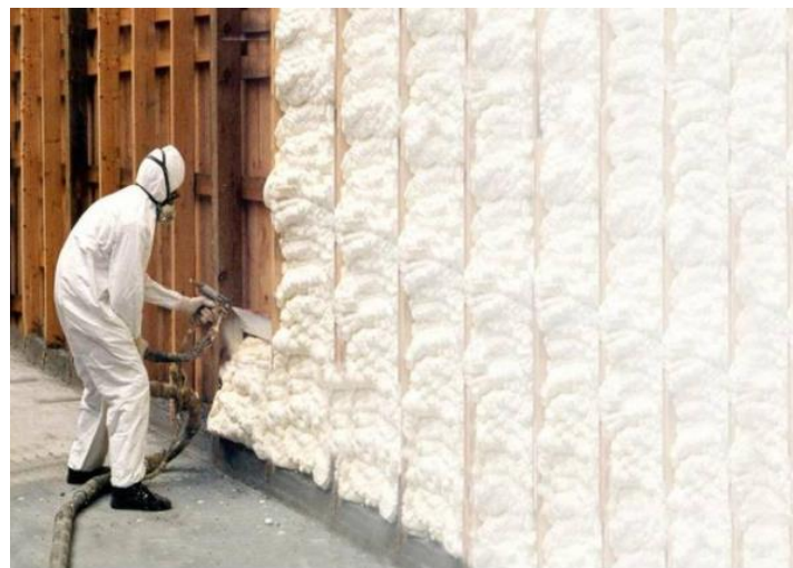
Ilustración 8. Poliuretano proyectado.
