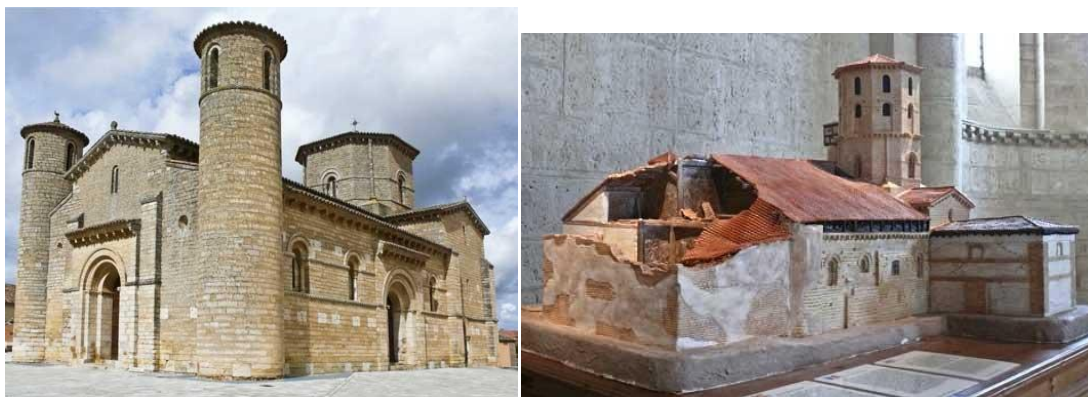
Imágenes 9 y 10. Comparativa de la iglesia de Frómista antes y después de su restauración.
