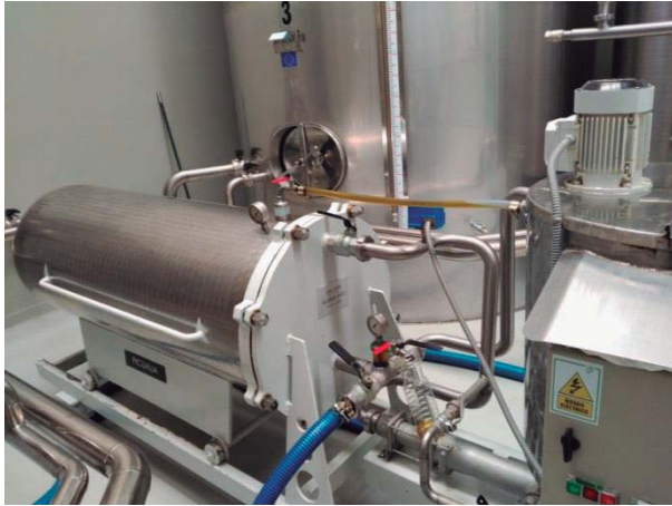
Ilustración 32: Filtradora en la sala de filtrado en Picualia. Fotografía de autor.
