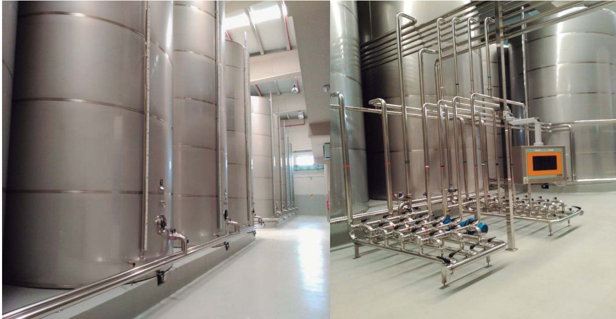
Ilustración 26: Válvulas de control de los depósitos de aceite. Fotografía del autor.
