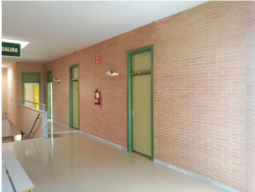
Figura 82. Foto pasillo baños planta superior pabellón.
