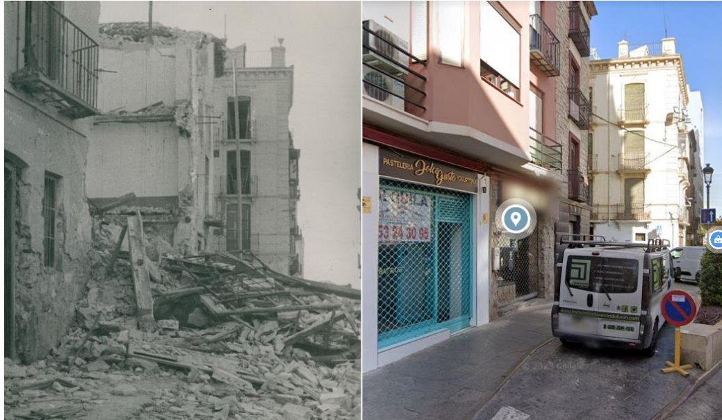
Imagen No. 4. Comparativa de la Calle Plaza de San Idelfonso, en la actualidad y momentos después de la destrucción por el Bombardeo de Jaén el 1 de abril de 1937. Imagen de la izquierda recuperada de Jaén Milla (2021b) y la imagen de la derecha recuperada de Google Maps, (2021)
