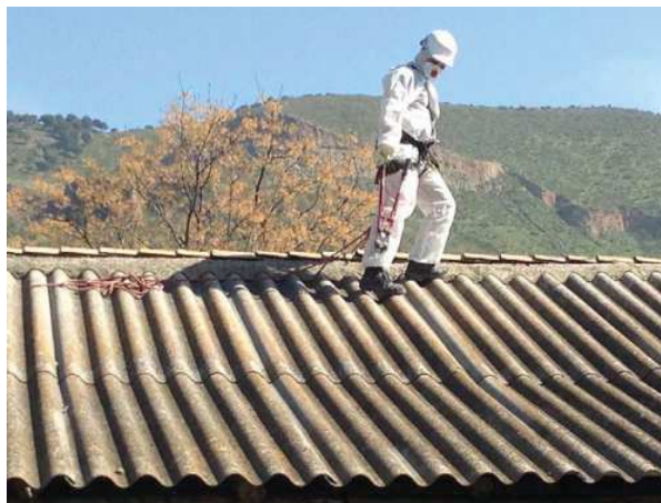
Figura 15 Placas onduladas de fibrocemento con amianto
