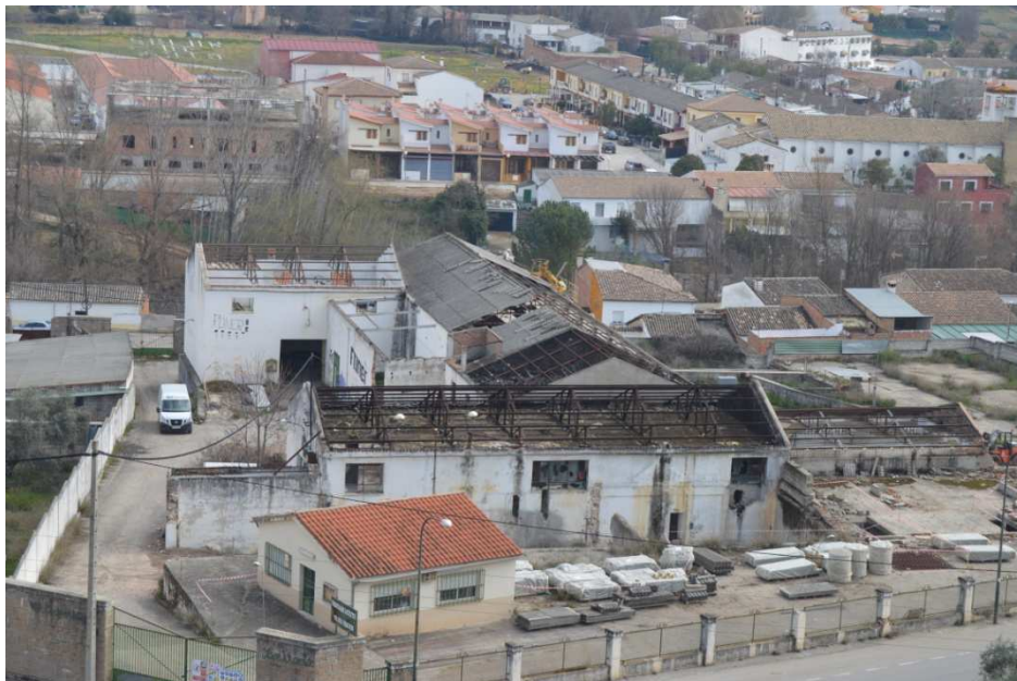
Figura 21 Vista global de la obra en proceso de retirada de amianto
