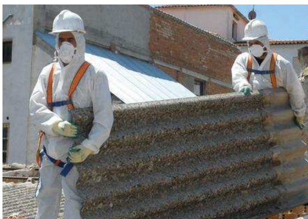
Figura 17 Operarios con EPI's correspondientes
