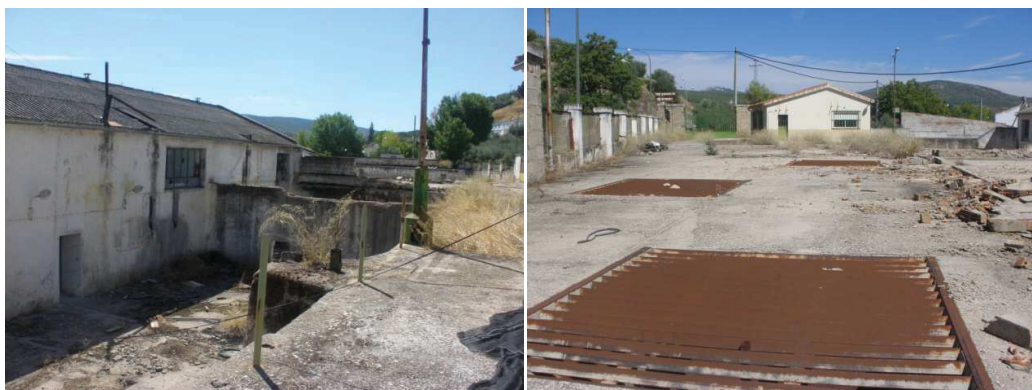
Figura 6 Zona de tolvas y recogida de aceituna
