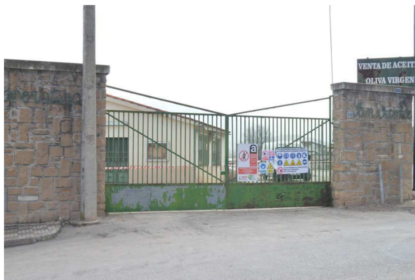
Figura 16 Señalización en acceso a la obra
