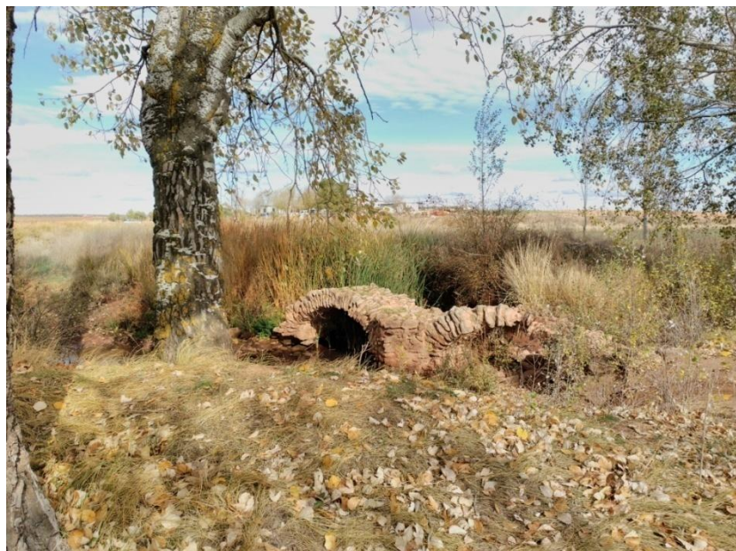
Figura 19. Fotografía del río Azuer, con uno de sus puentes romanos del año 197 a.C. En el árbol que se muestra a la izquierda es donde se colocó el medidor de temperatura para la ribera.
