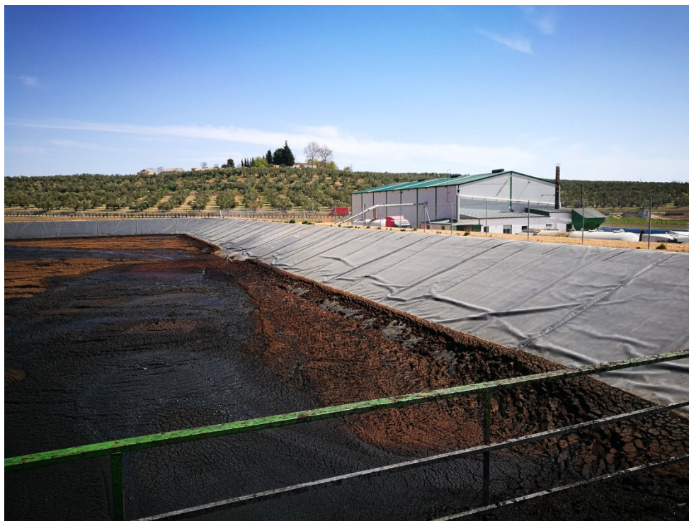
Imagen 4. Vista general de la instalación de secado y repaso de orujo. Fuente BIOLIZA.
