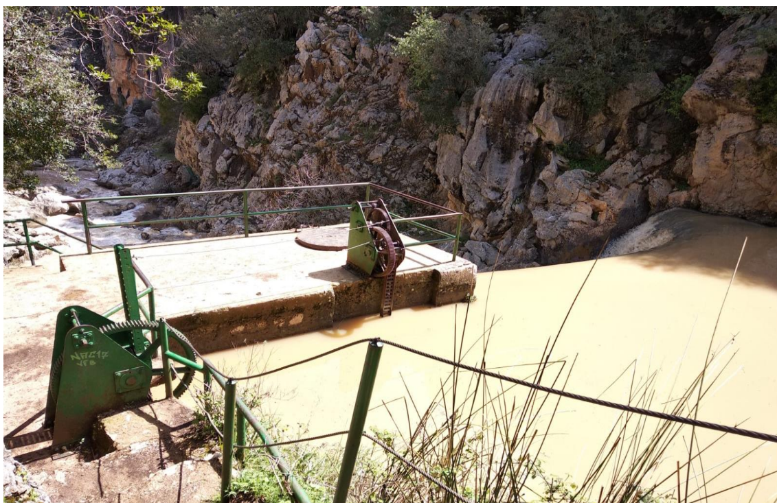
Ilustración 9 Toma y Azud
