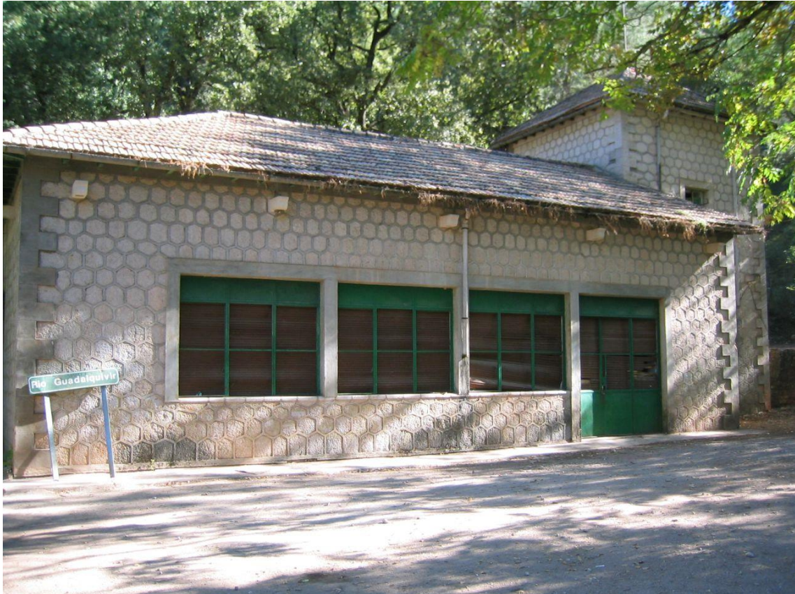
Ilustración 3 Sala de máquinas
