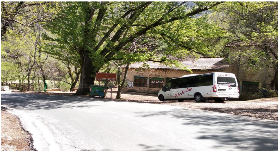
Ilustración 6 Acceso al edificio de la central
