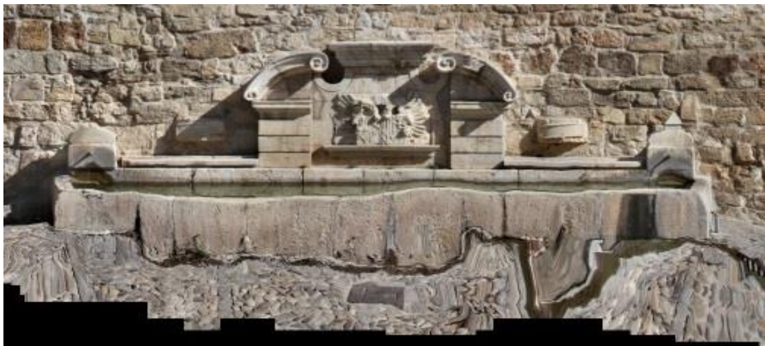
Figura 3-35. Errores groseros en la base de la fuente
