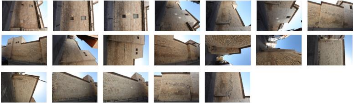
Figura 3-50. Imágenes para la rectificación de la fachada Oeste
