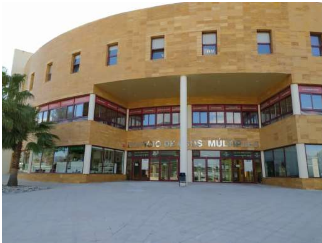
Ilustración 2. Edificio C-4 Usos Múltiples
