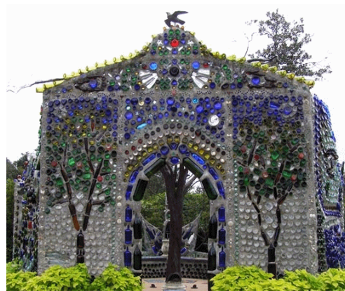
Imagen 15.- Ejemplo del uso de botellas de vidrio recicladas en la arquitectura y construcción
