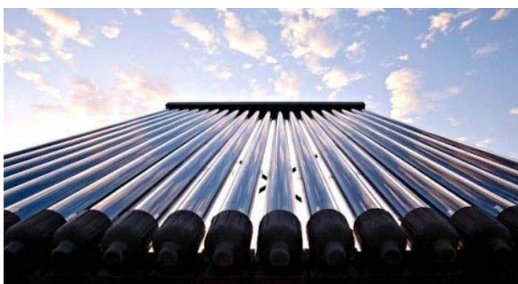
Imagen 1. Colector de tubos de vacío
