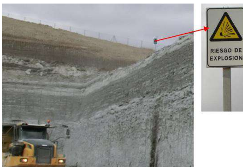
Figura 3.14 — Vallado del perímetro de la mina y señales de aviso de voladuras.
