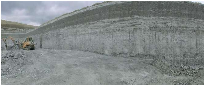
Figura 6.2 — Primer nivel de precorte descubierto.
