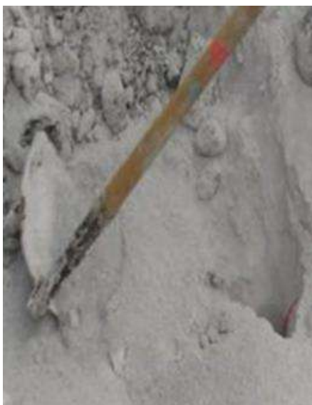
Figura 3.10 — Retacado con detritus de la perforación.
