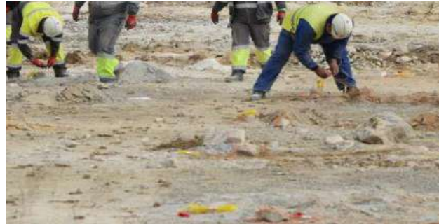
Figura 3.11 — Equipo de artilleros realizando la conexión de los barrenos.
