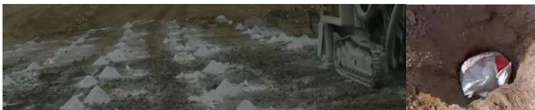
Figura 3.2 — Barreno tapado con un saco.
