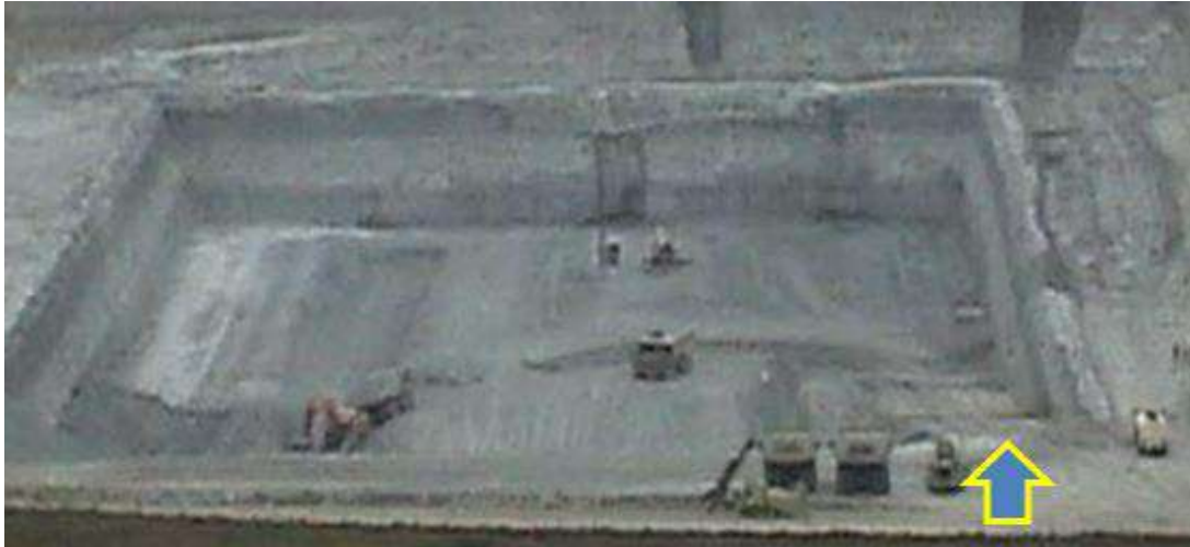
Figura 3.1 — Rampa de acceso, en piscina en ejecución.
