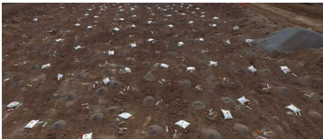
Figura 3.7 — Distribución de explosivo y detonadores en la voladura.
