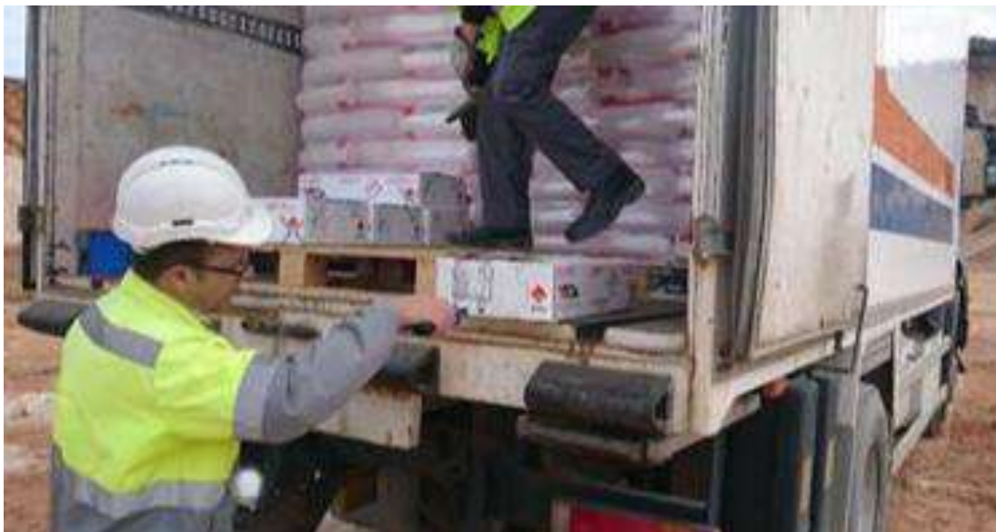
Figura 3.6 — Descarga y comprobación de cantidades y número de serie de explosivo.
