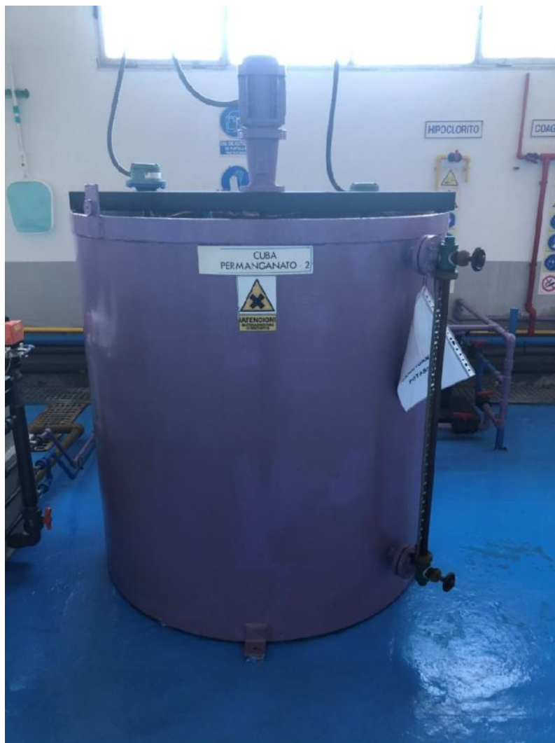
Ilustración 14. Cuba almacenamiento permanganato de potasio ETAP Linares
