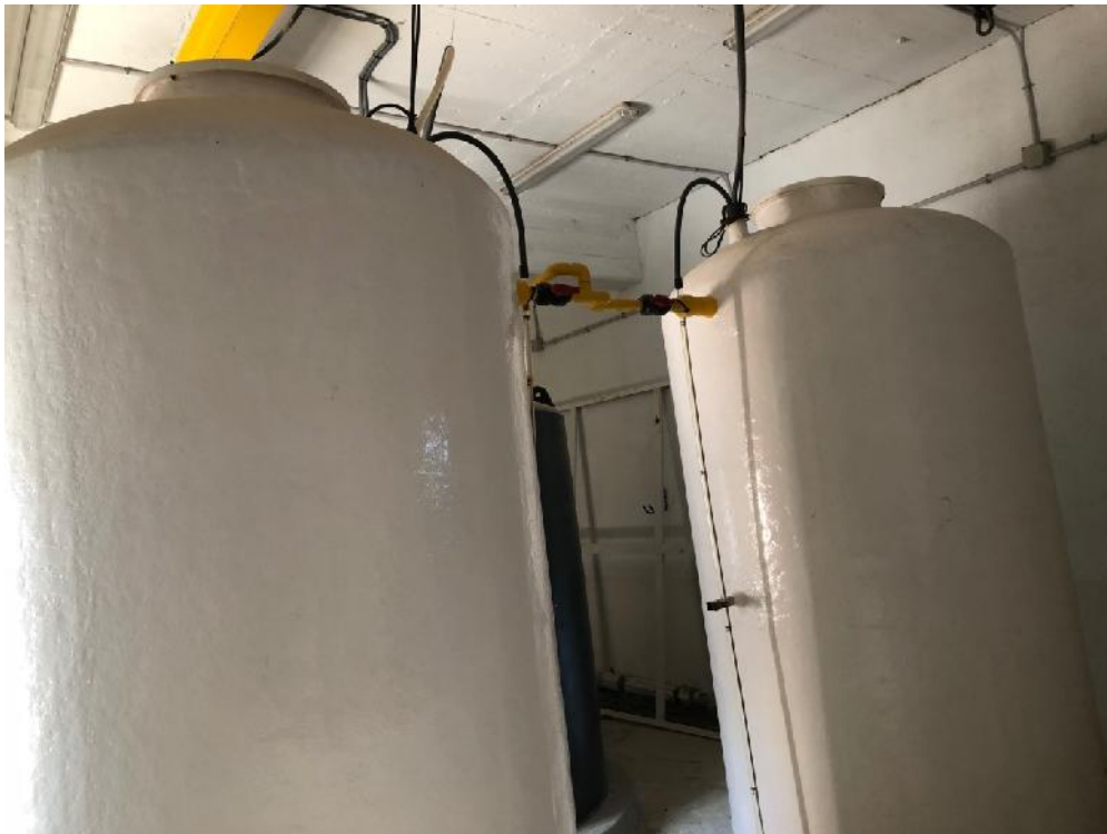
Ilustración 18. Tanques de día hipoclorito sódico ETAP Linares (2)
