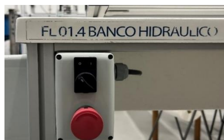
Ilustración 84. Interruptores bomba centrífuga
