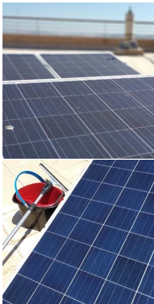
Figura 4.7: GFV con suciedad (arriba) y GFV limpio (abajo)
