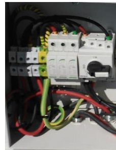
Figura 3.12: Protecciones en continua
