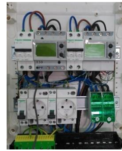
Figura 3.11: Protecciones en alterna y cargas
