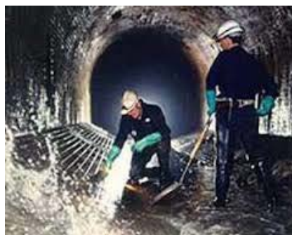
Figura 58. Mantenimiento y limpieza de un túnel
