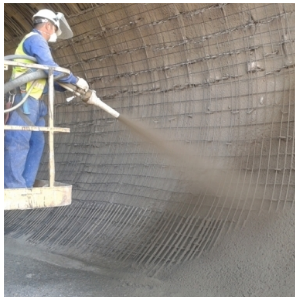
Figura 38. Vertido del hormigón proyectado
