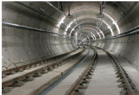
Figura 6. Impermeabilización de un túnel
