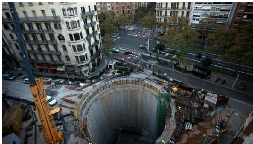
Figura 51. Instantánea durante la construcción del pozo situado en el cruce de las calles Mallorca y Padilla en Barcelona
