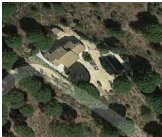
Ilustración 48: Vista del tejado de la vivienda
