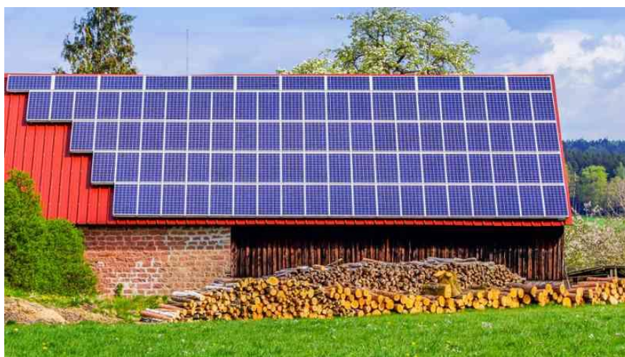
Ilustración 10: Módulos colocados de forma coplanar
