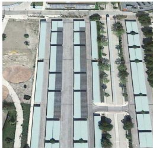
Figura 3.2: Generadores en el aparcamiento. Sistema 1 (a la izquierda) y sistema 2 (a la derecha)
