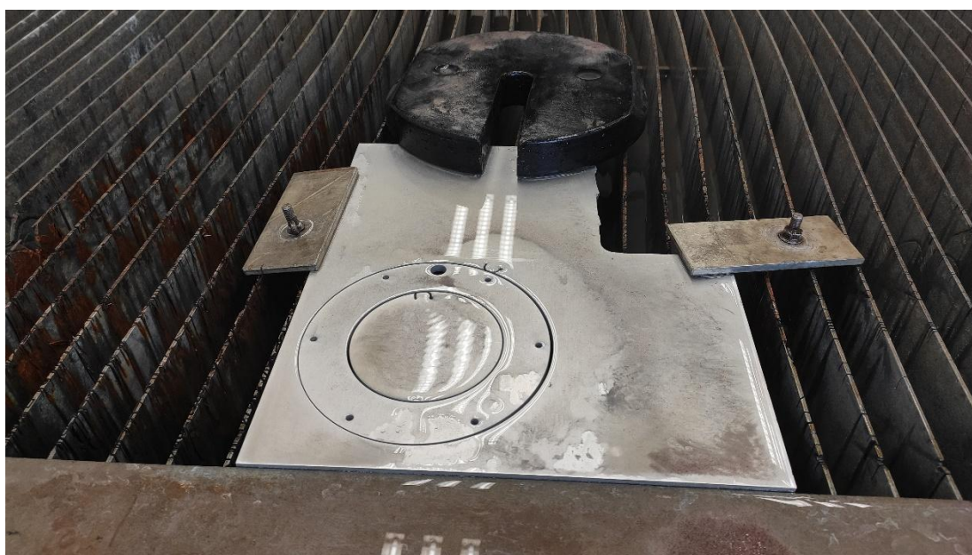
Figura 72. Anillo metálico del distribuidor cortado mediante chorro por agua.
