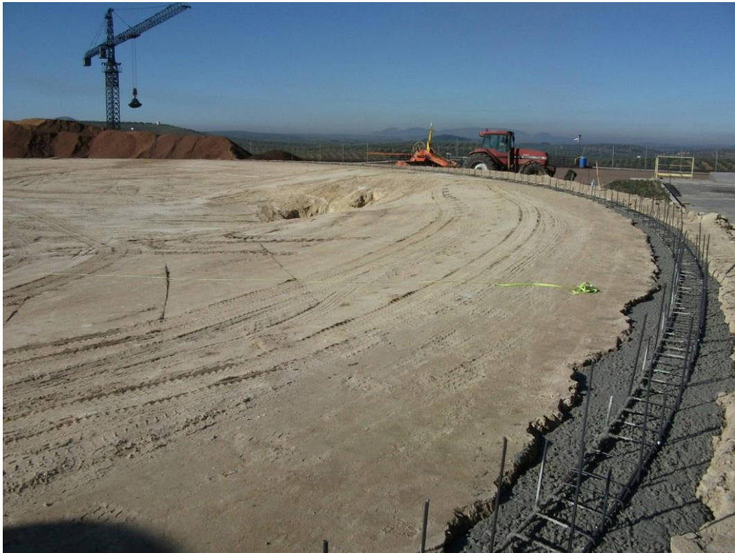
Figura 40. Fase de cimentación. Construcción de zuncho perimetral de hormigón armado para instalación del depósito prefabricado ILURCO [23]
