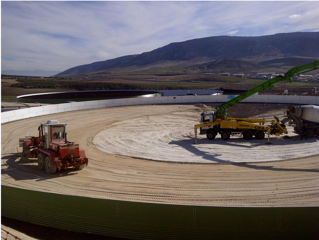
Figura 39. Fase de movimiento de tierras para instalación del depósito prefabricado ILURCO [23]
