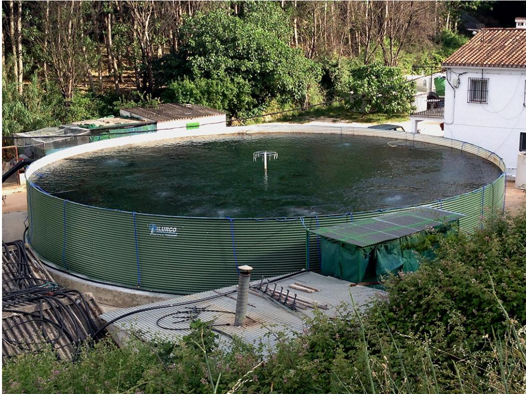
Figura 36. Depósito de riego tipo tanque australiano de ILURCO [23]
