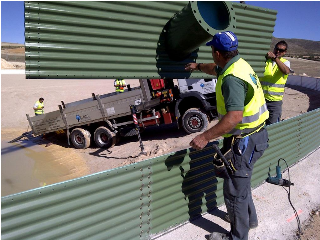
Figura 41. Fase de montaje para instalación del depósito prefabricado ILURCO [23]
