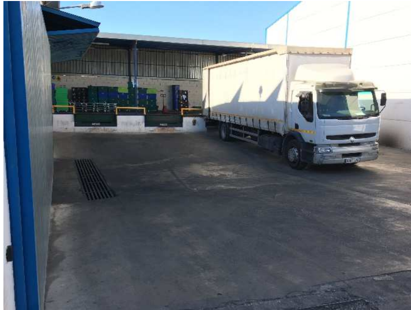
Figura 6.4.2. Muelle de carga de producto terminado. (Fotografía del autor).
