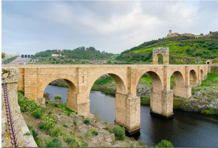
Figura 2.15. Puente de Alcántara, Cáceres
