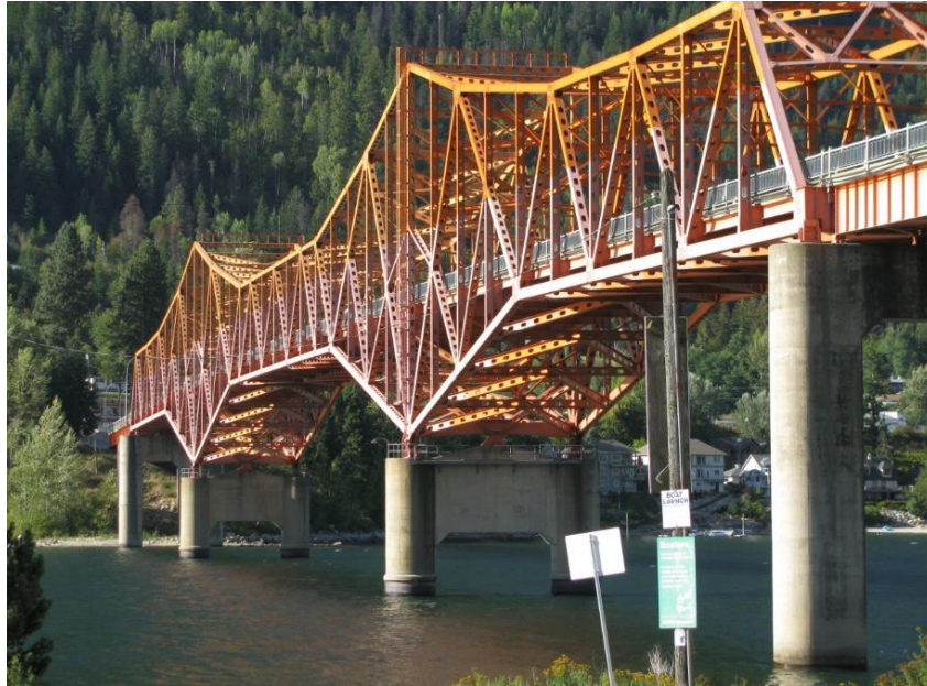
Figura 2.19. Puente de armadura.
