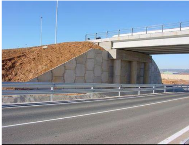
Figura 2.8. Estribo de tierra armada
