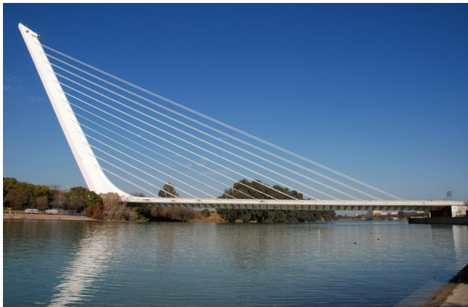
Figura 2.22. Puente del Alamillo, Sevilla
