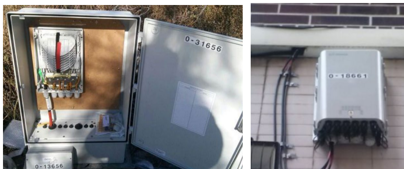
Figura 3.1_. Cajas de terminación óptica.
