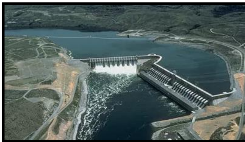
Ilustración 2.-Central de agua fluyente
