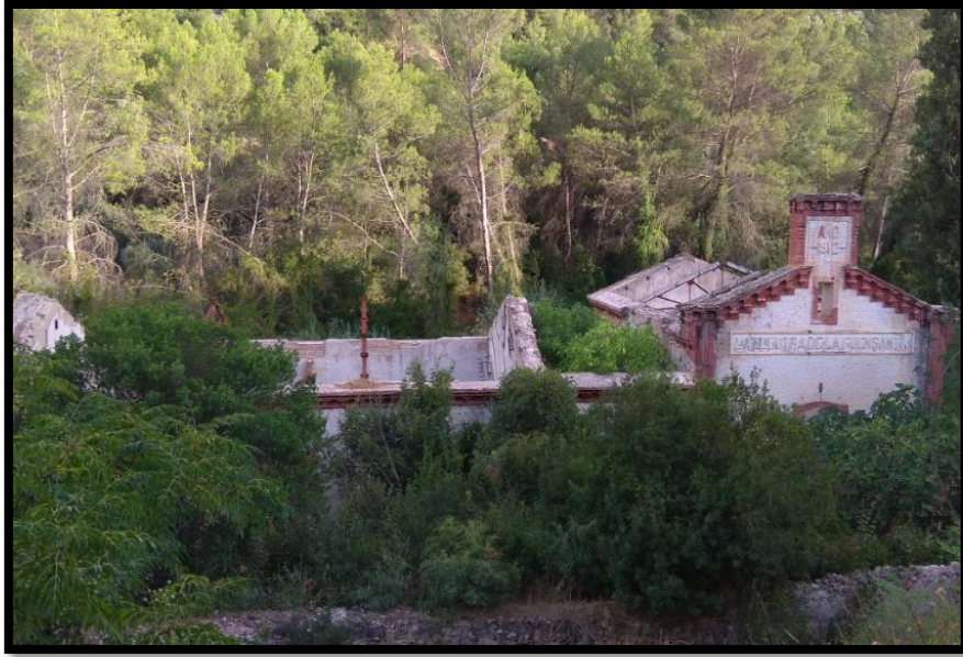
Ilustración 14.-Edificio de la central
