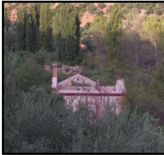
Ilustración 11.-Edificio de la central y azud al fondo
