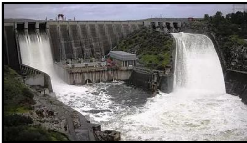
Ilustración 5.-Central de bombeo
