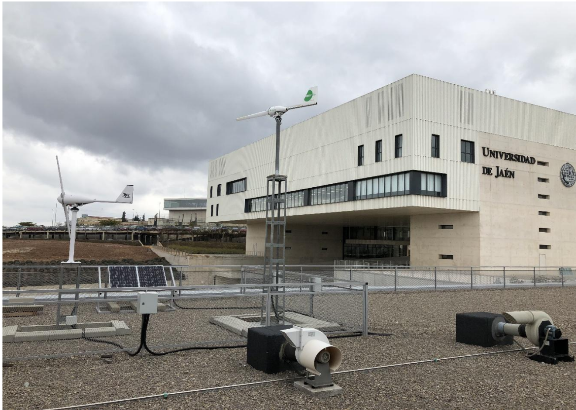
Figura 4.21- Instalación. Fuente propia.
