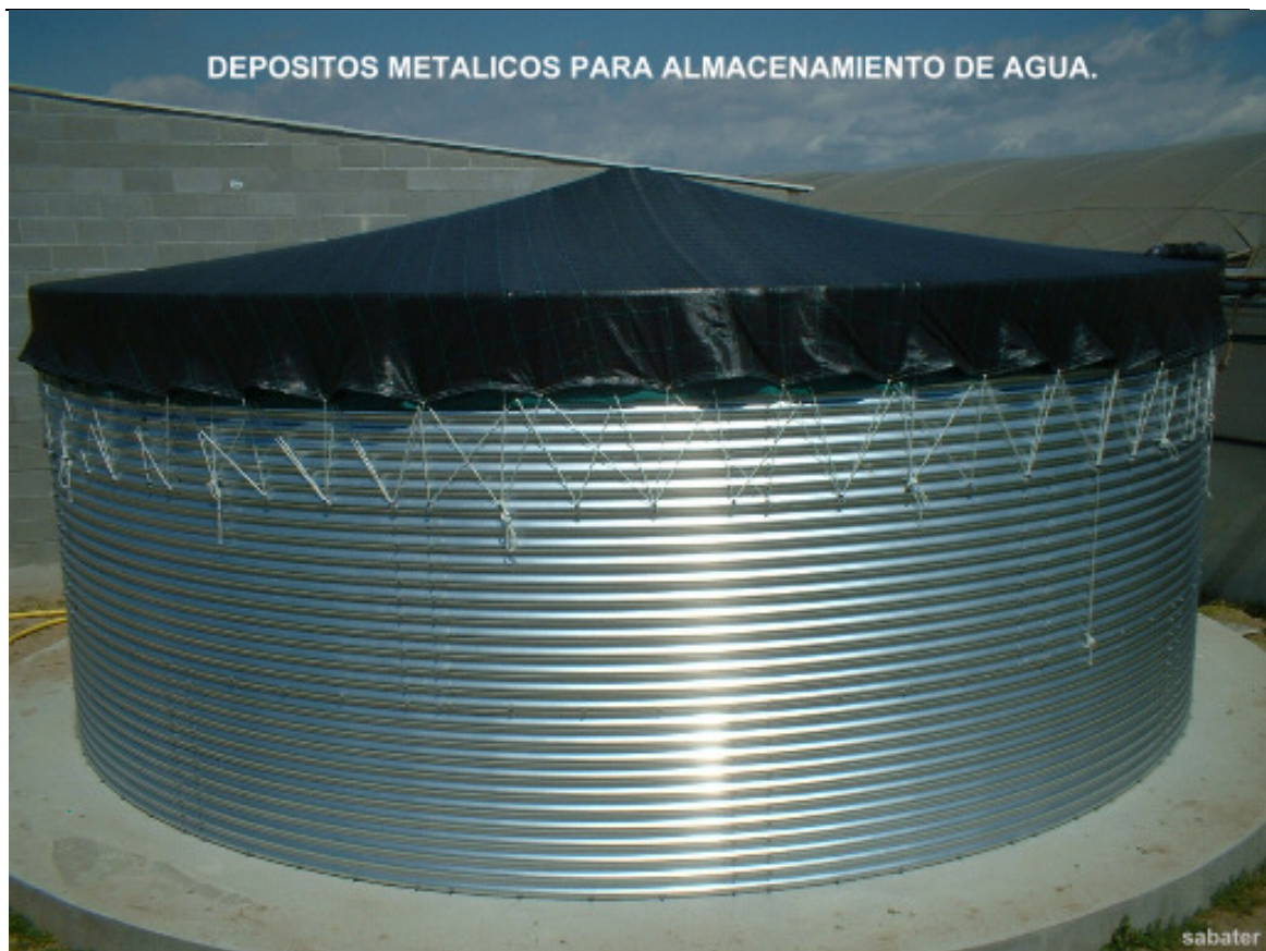
Figura nº 18: Depósito prefabricado de chapa metálica.
