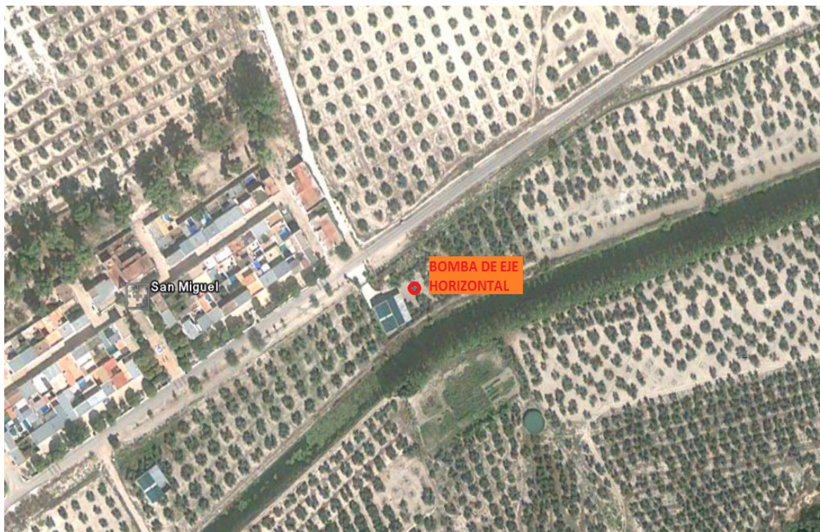
Figura nº 6: Situación de la bomba de eje horizontal.
