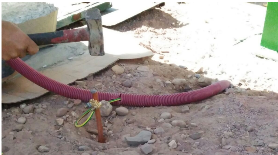
Imagen 10. Enterramiento de una puesta a tierra.
