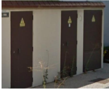
Ilustración 5. Centro de transformación eléctrica
