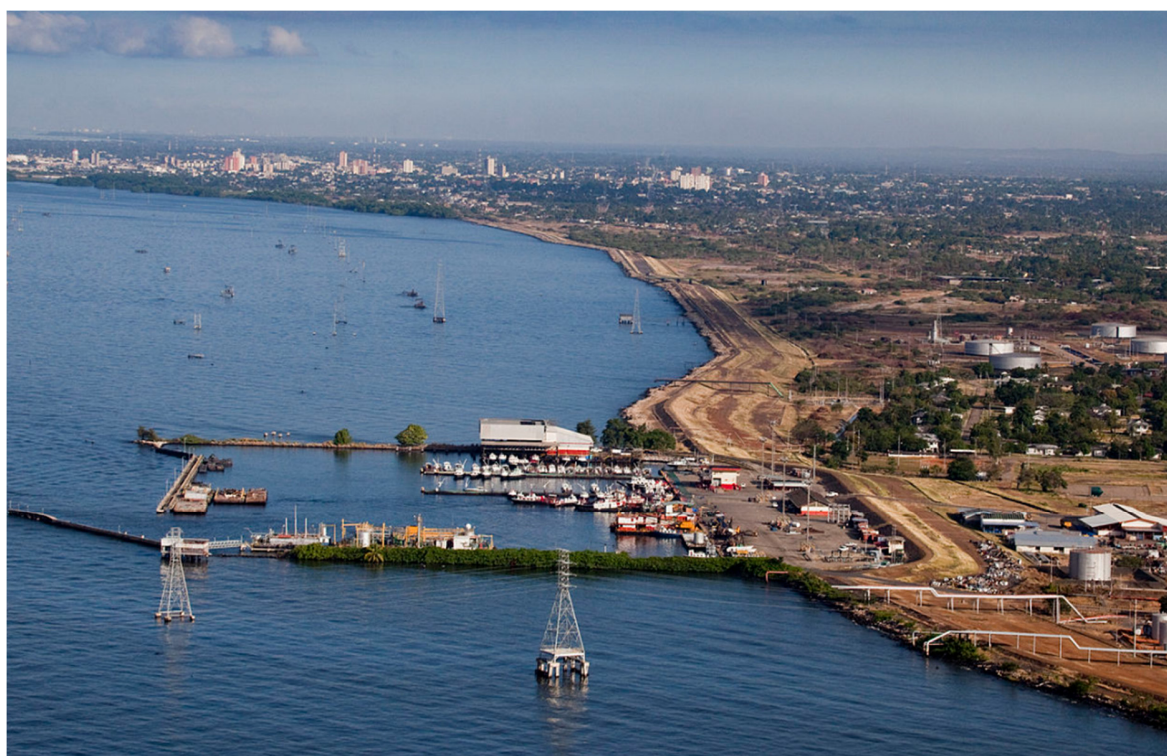
Figura 3. Vista aérea Lagunillas, Muro de Contención - Ciudad Ojeda. Fuente: Google Imagen.
