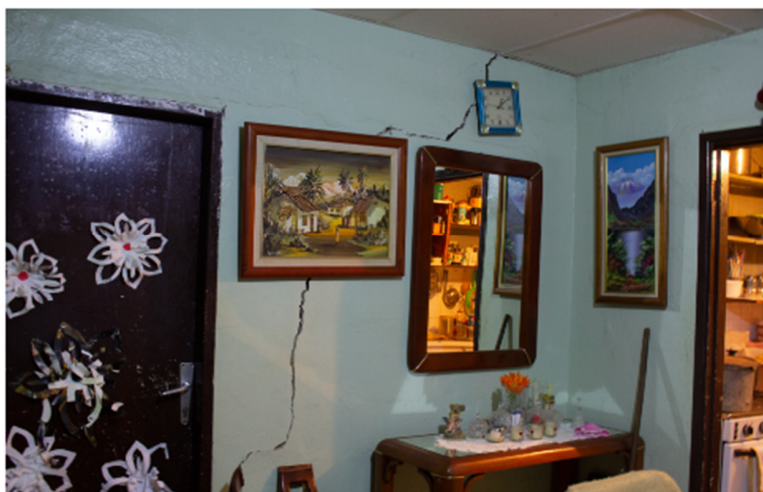
Figura 70. Ejemplos de daños en viviendas causados por las subsidencias en el campo Petrolero de Lagunillas de la Costa Oriental de Maracaibo. Fuente: https://www.bbc.com/mundo/noticias-america-latina-41913823 .
