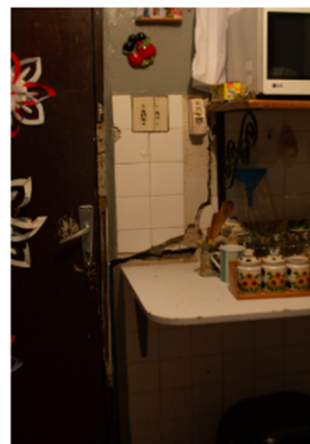
Figura 70. Ejemplos de daños en viviendas causados por las subsidencias en el campo Petrolero de Lagunillas de la Costa Oriental de Maracaibo. Fuente: https://www.bbc.com/mundo/noticias-america-latina-41913823 .
