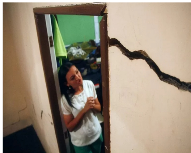
Figura 71. Ejemplos de daños en viviendas causados por las subsidencias: A) Vivienda en Campo Lagunillas, (B, C) Grietas en paredes. Fuente: https://www.bbc.com/mundo/noticias-america-latina-41913823 .
