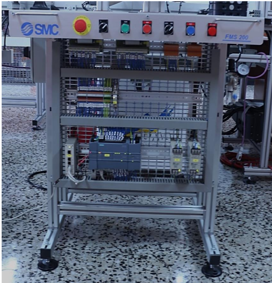
Figura 15 Vista frontal de la estructura de las estaciones
