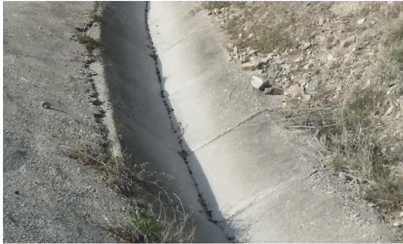
Figura nº 2 – Cuneta actual, las nuevas cunetas respetarán estas dimensiones. Fuente: Fotografía propia.
