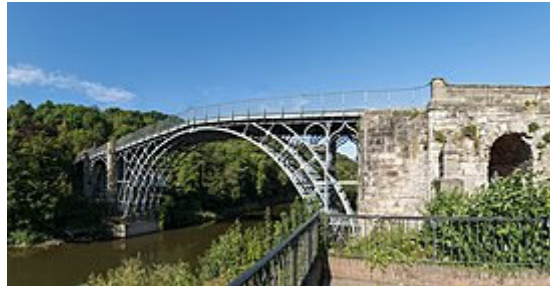
Imagen 8: Iron Bridge o puente de Hierro.
