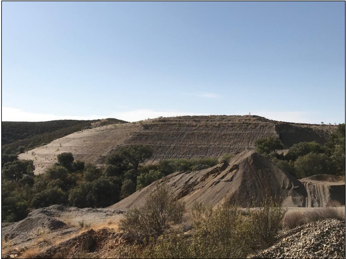
Figura 2: Talud principal de la presa de lodos de La Manzana.
