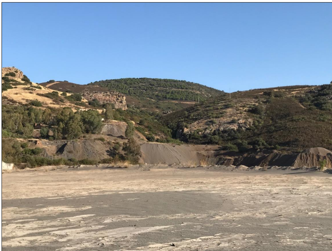
Figura 6: Aspecto de la parte superior de la presa de lodos de La Manzana.
