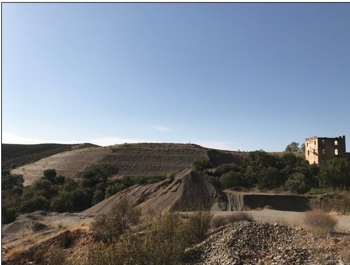
Figura 26: Imagen en segundo plano del talud resultante de la construcción de la presa de lodos de La Manzana
