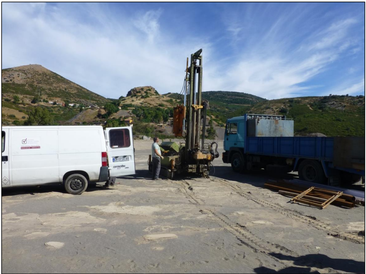
Figura 8: Imagen de la realización del sondeo de investigación en la presa de lodos de La Manzana.
