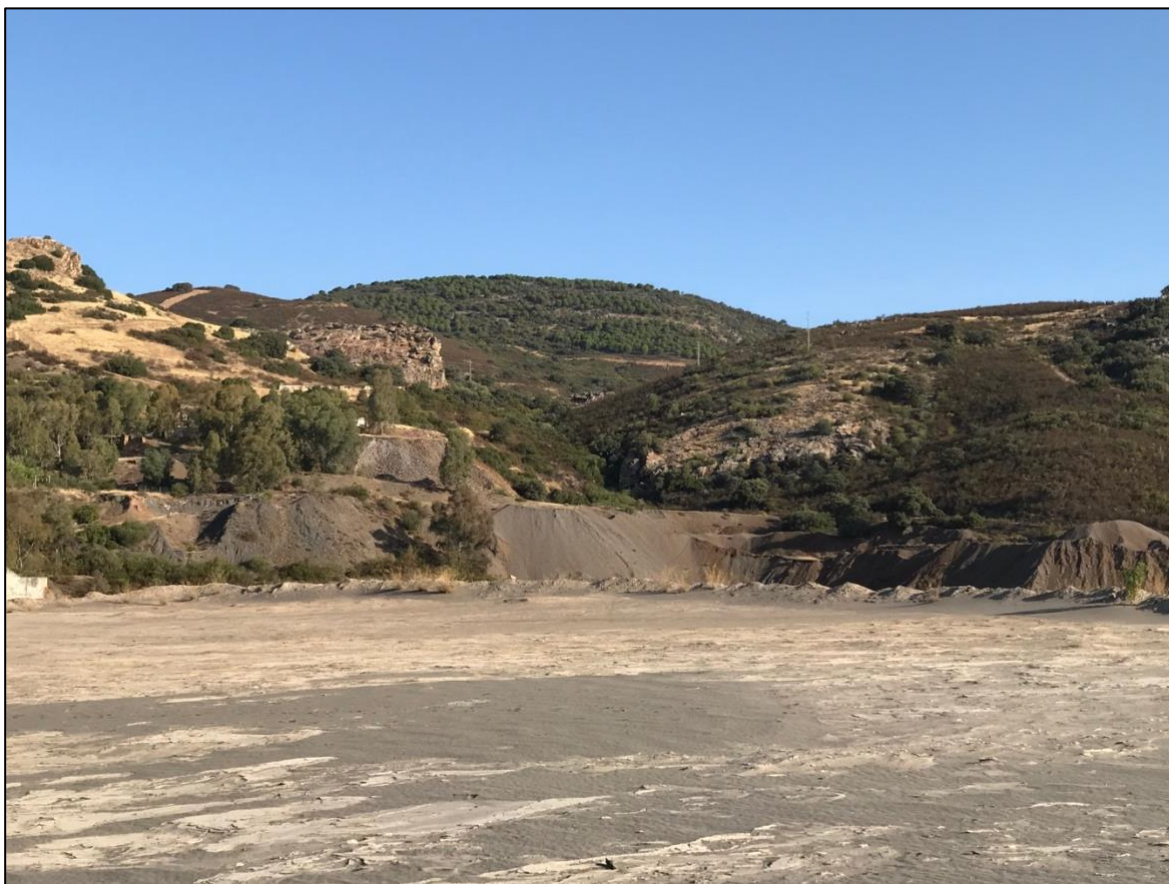
Figura 25: Imagen de la explanada superficial de la presa de lodos de La Manzana.
