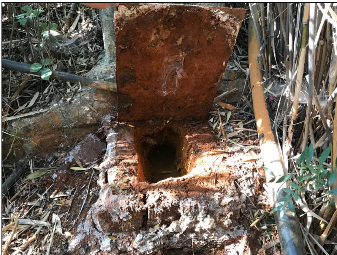
Figura 28: Salida de agua del dren de la base de la presa de lodos de La Manzana.
