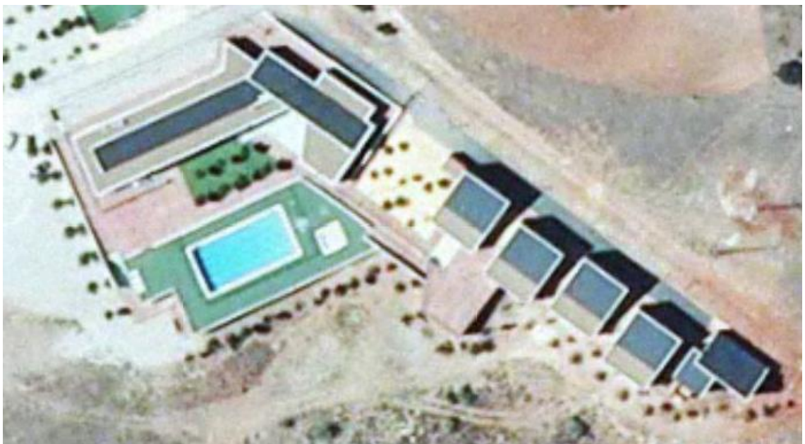
Figura 5 Foto satélite del edificio.
