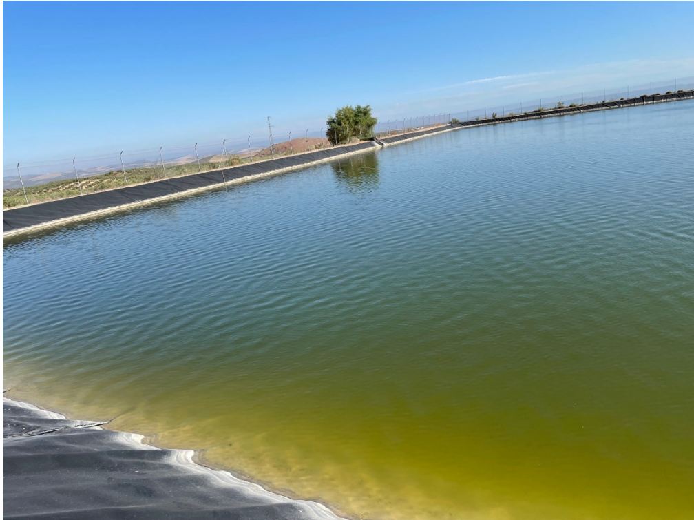
Ilustración 8. Balsa donde se ejecuta la instalación
