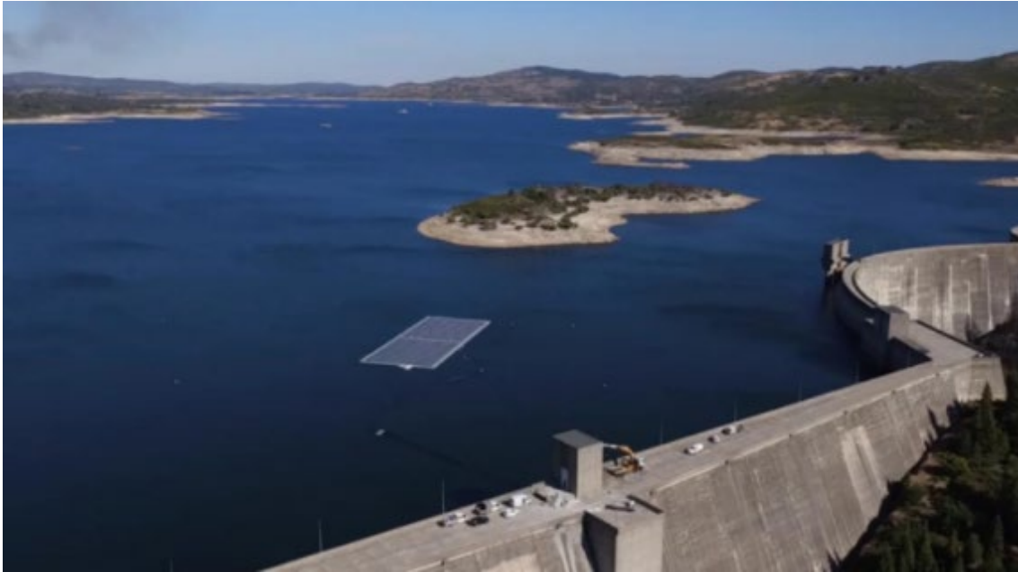
Ilustración 2. Primera instalación fotovoltaica flotante conectada a una central hidroeléctrica en Montalegre, Portugal (Fuente: pvtech.org)
