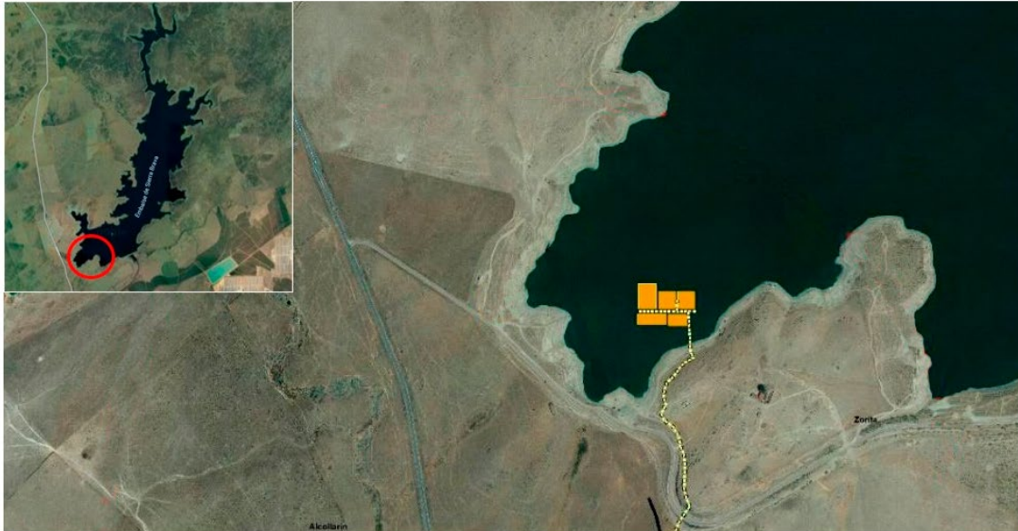
Ilustración 3. Embalse de Sierra Brava, Extremadura. Donde se ubica la instalación flotante de ACCIONA. (Fuente: Web de Acciona)
