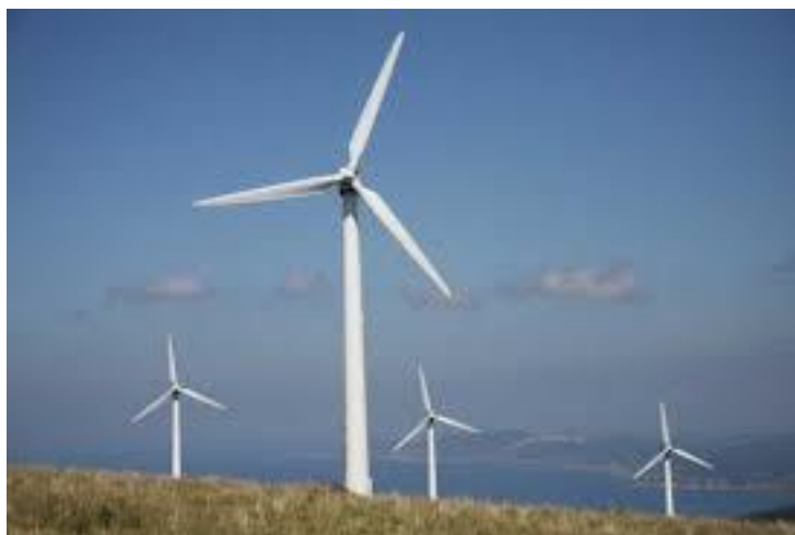
Ilustración 31.- Aerogenerador tripala (www.OPEXenergy.com).
