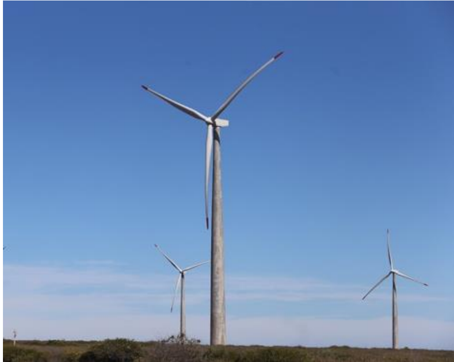
Ilustración 34.- Aerogenerador con torre tubular de hormigón (www.acciona.es).
