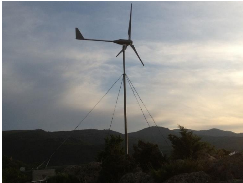
Ilustración 35.- Aerogenerador con torre tubular de acero atirantada (www.SørenKrohn.com).
