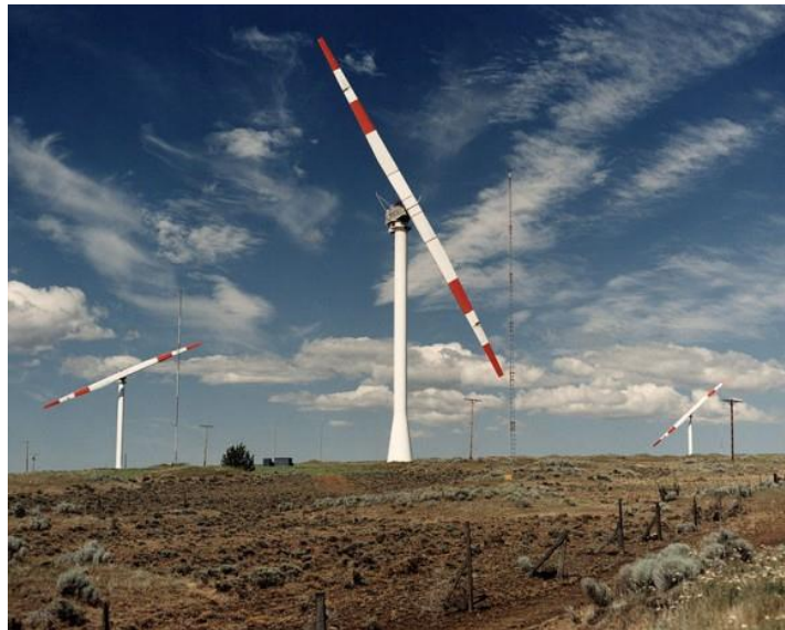
Ilustración 30.- Aerogenerador bipala (www.OPEXenergy.com).
