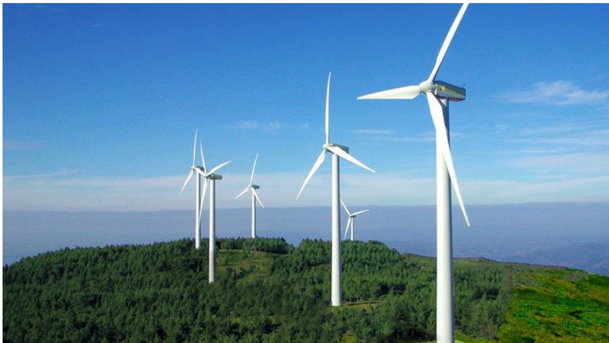
Ilustración 33.- Aerogenerador con torre tubular de acero (www.iberdrola.com).
