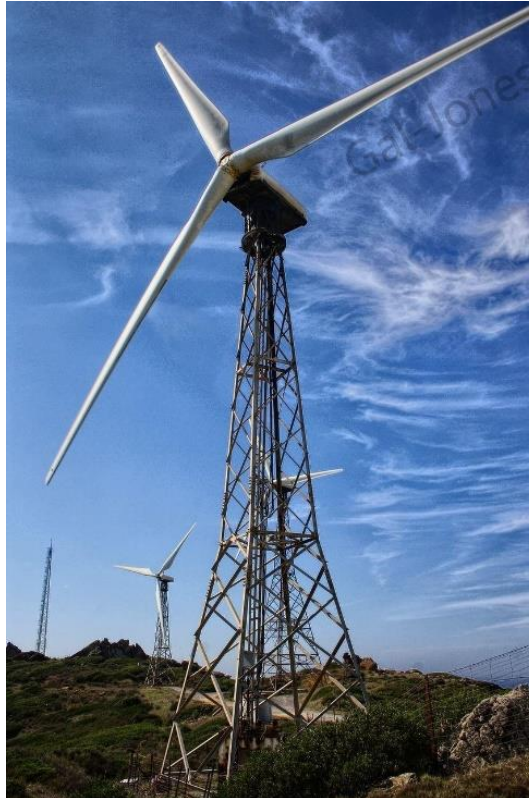
Ilustración 36.- Aerogenerador con torre en celosía (www.Gal-Jones.com).
