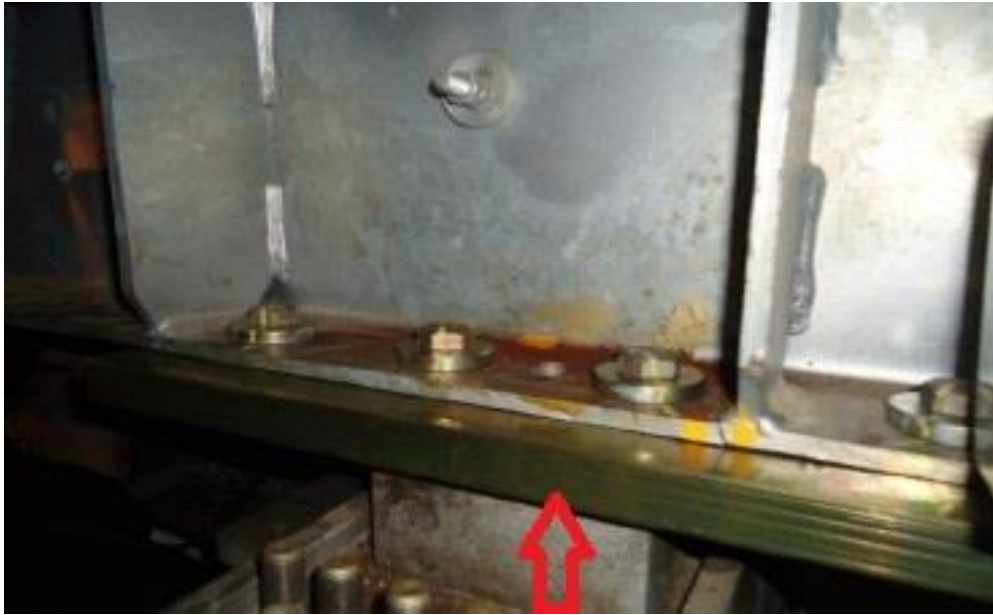
Ilustración 52.- Aumento de superficie de la viga mediante un chapón de acero.
