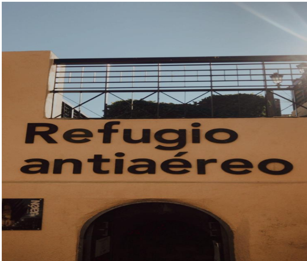
Figura 7 Exterior del refugio.
