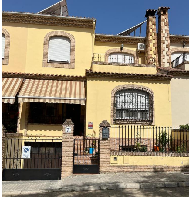
Figura 1.1. Vivienda vista desde pie de calle
