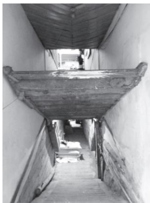
Figura 1.4. Escalera pivotante abierta vista desde el acceso
