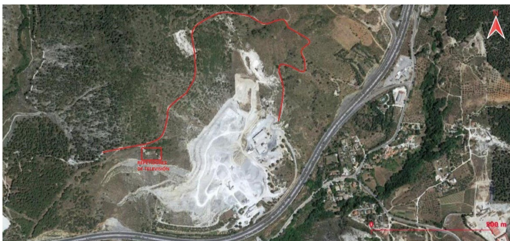
Figura 9.1. Acceso a la zona alta de la explotación.
