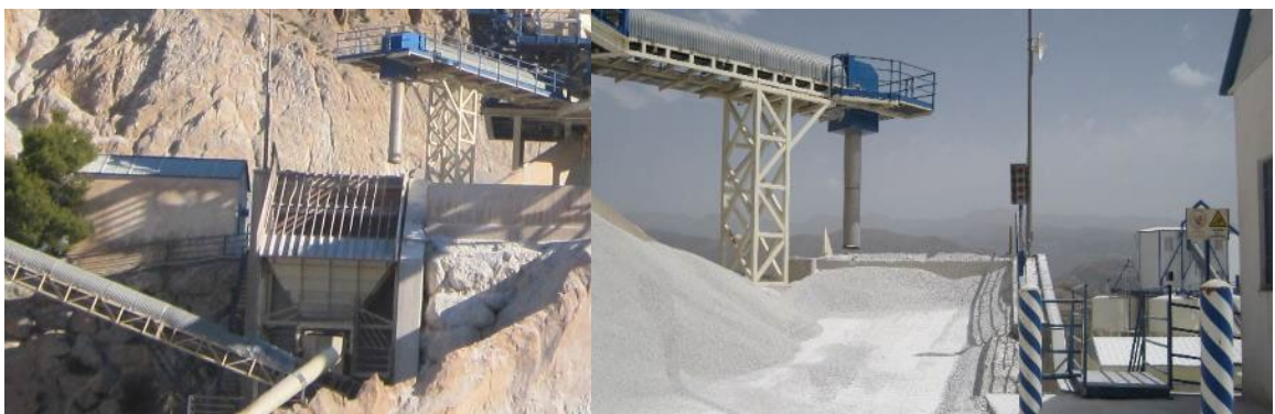
Imagen 5. Vista de tolva de recepción para segunda línea de producción.
