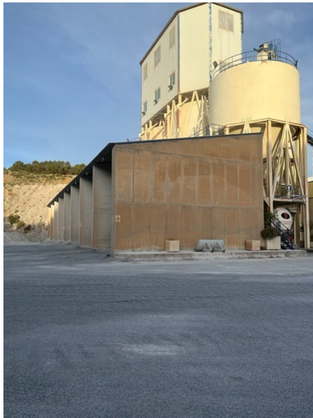
Imagen 9. Caseta cribas, silos y trojes.
