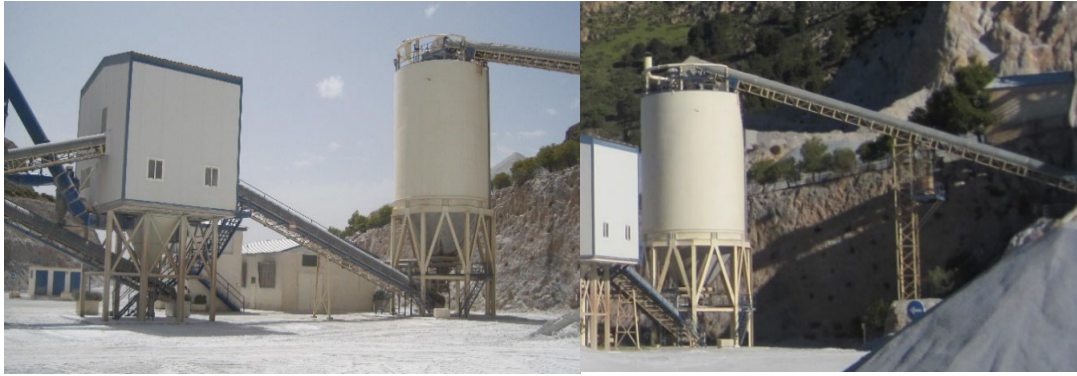
Imagen 6. Silo principal y caseta de los molinos.
