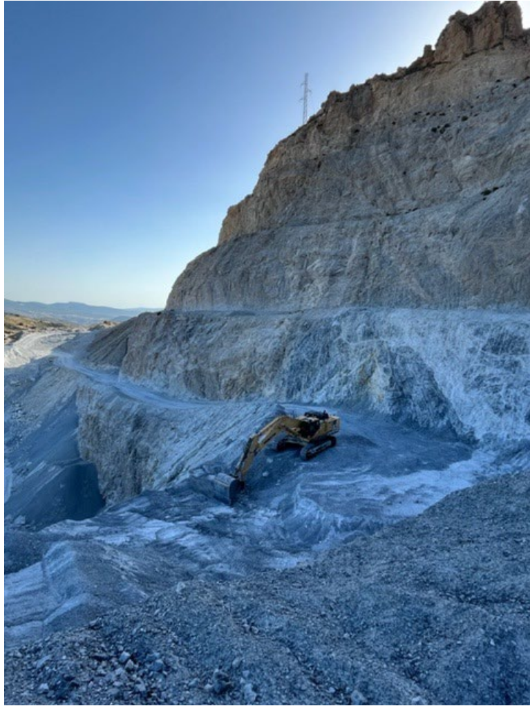
Imagen 10. Retroexcavadora en el frente de trabajo.
