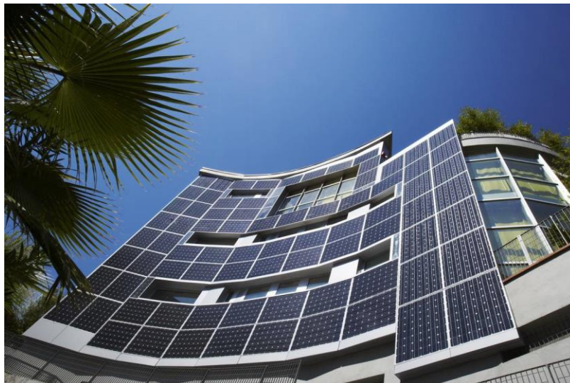
Figura 16. Estructura de paneles solares en tejados inclinados. Fuente: tutiendaenergética.es
