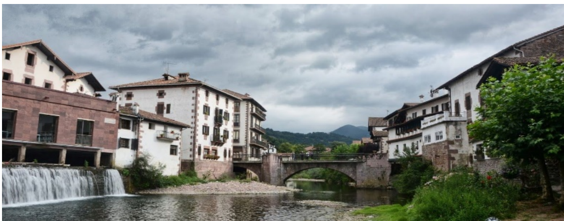
Ilustración 10 Puente de Txokoto Fuente: https://lh5.googleusercontent.com/-lQ3sGLy7S78/Uiwq6j1LtDI/AAAAAAAAADk/aBWki4fvTqs/w1465-h754-no/0DSC_9957.jpg
