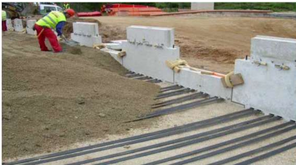
Figura 9.17. Colocación de flejes de acero para la mejora de rozamiento. Fuente: apuntes procedimientos de construcción II.
