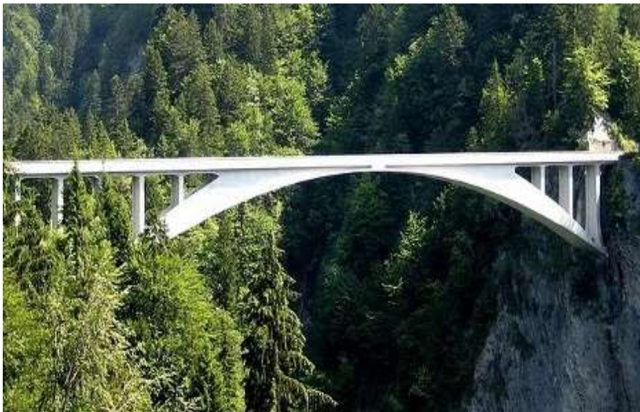
Figura 9.11. Puente arco de hormigón armado. Fuente: civilgeeks.com
