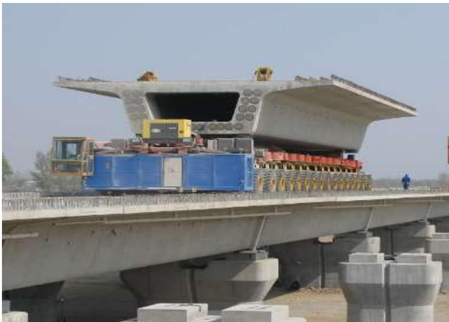
Figura 9.23. Tablero prefabricado en cajón. Fuente: pacadar.es.
