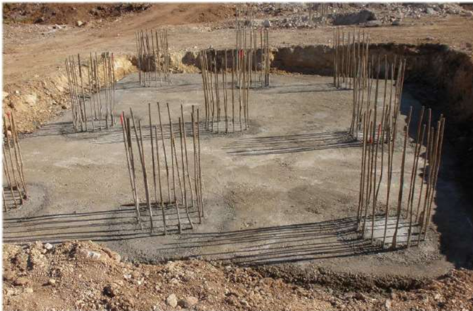
Figura 9.5. Hormigón de limpieza con armadura de espera para ejecución de encepado. Fuente: apuntes de procedimientos de construcción II.
