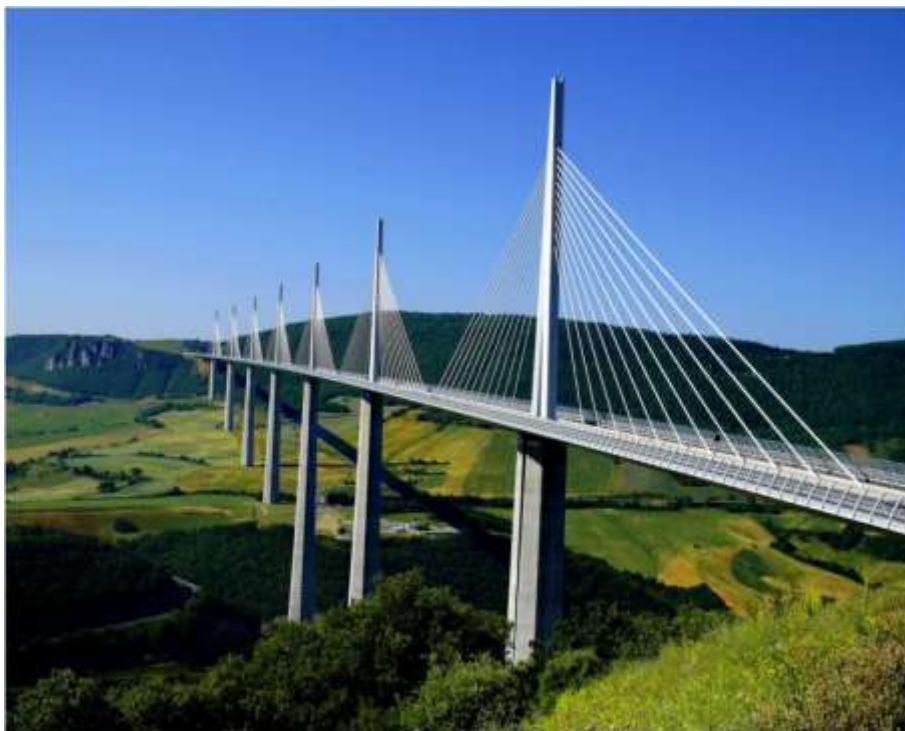
Figura 9.9. Pilonos. Fuente: apuntes procedimientos de construcción II.
