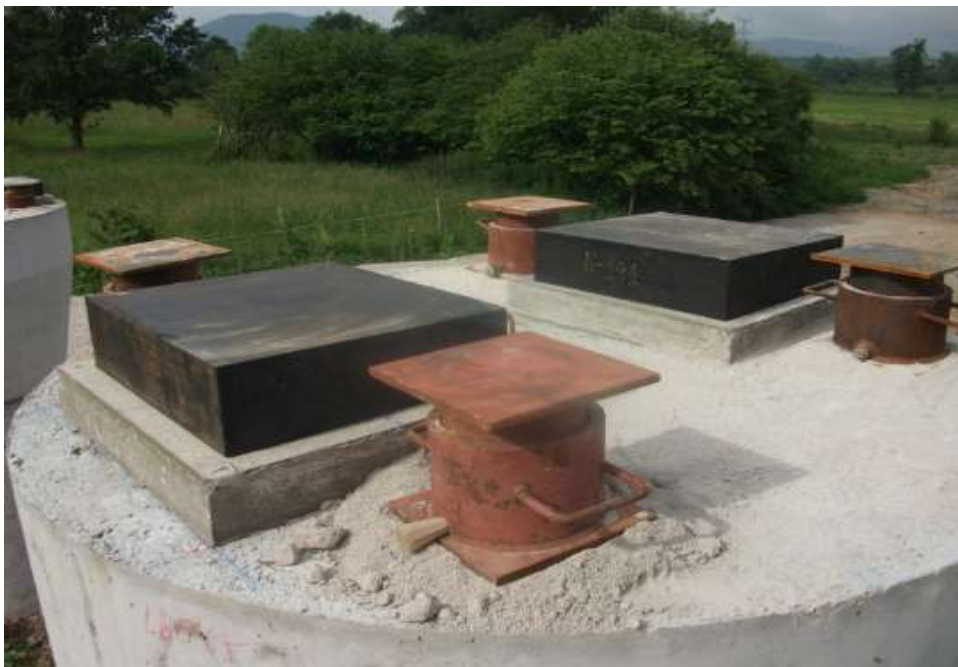
Figura 9.19. Neopreno sobre mortero de nivelación. Fuente: Google.
