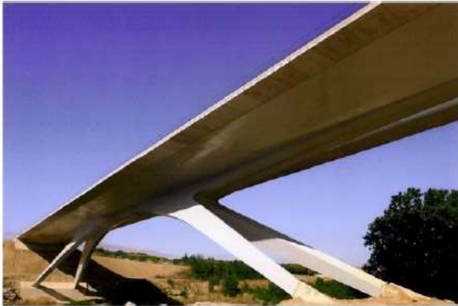
Figura 9.8. Jabalcones. Fuente: apuntes procedimientos de construcción II.
