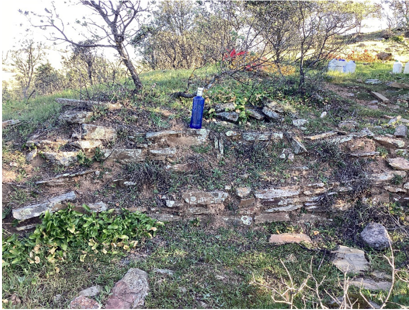
Figura. 1.4. Altura máxima que alcanza el muro en el enclave.
