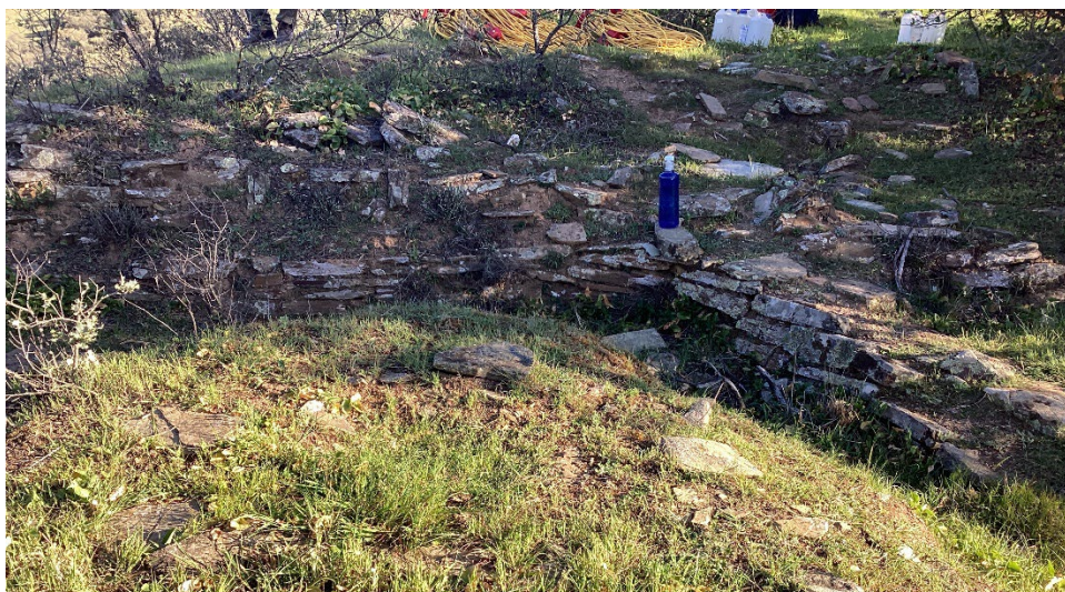
Figura. 1.3. Vista de uno de los muros en el que se aprecia la disminución gradual en altura hacia la zona abierta.
