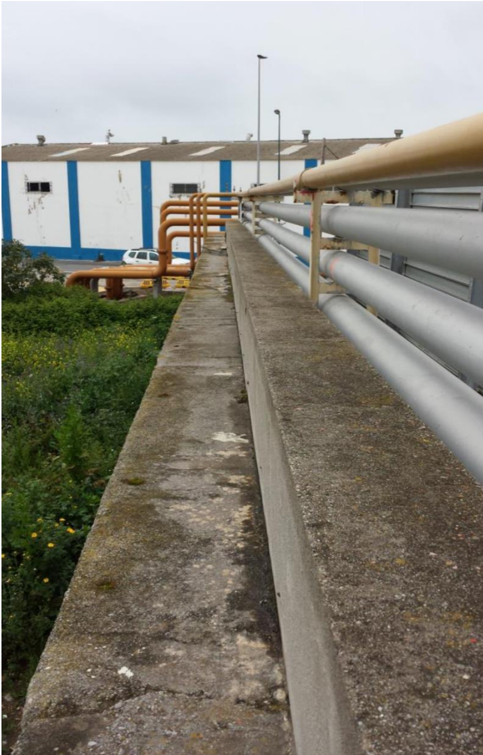
Figura 7 Espaldón existente
