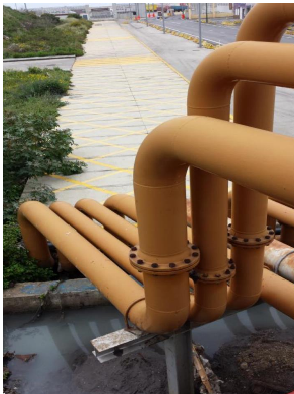
Figura 5 Zona conexión con galería existente
