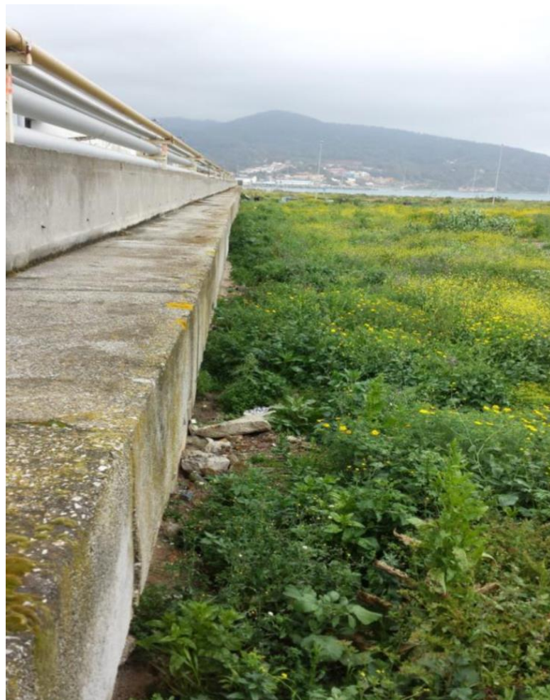
Figura 3 Ubicación nueva galería
