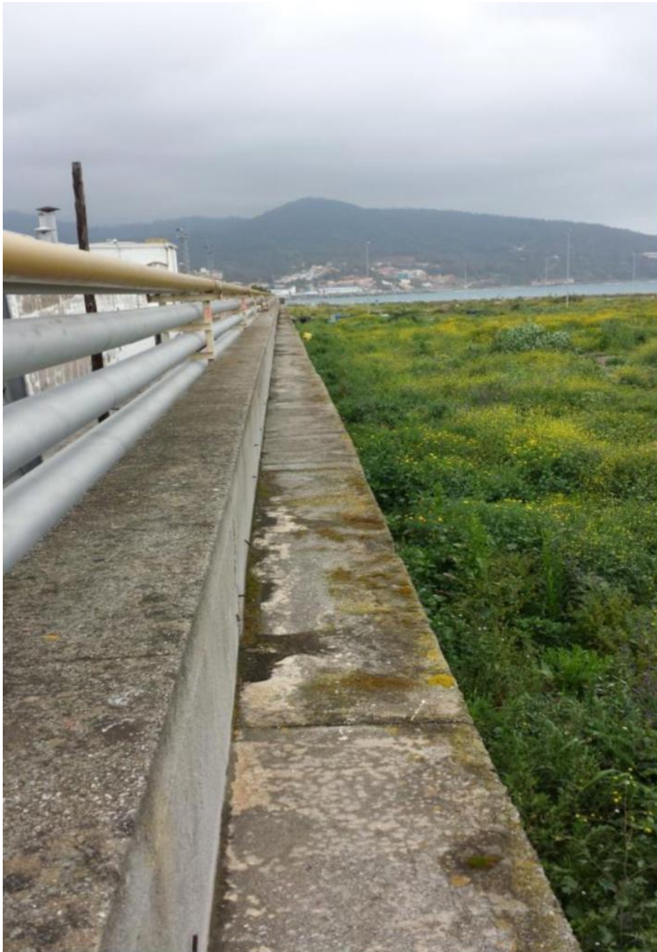
Figura 1 Ubicación nueva galería
